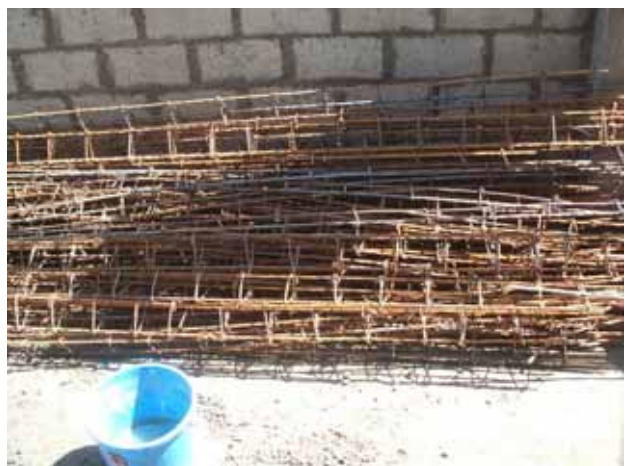
梁、まぐさの中には鉄筋をいれて、コンクリートで固める。
