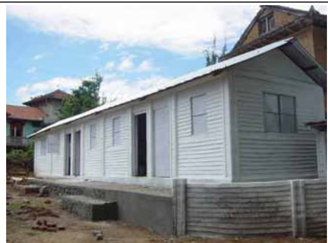
住民がアイデアと労働力を分かち合い、使いやすい保健所に近づいていく。ここは、破壊された村役場跡に建設されたので、床が地面より高い。
