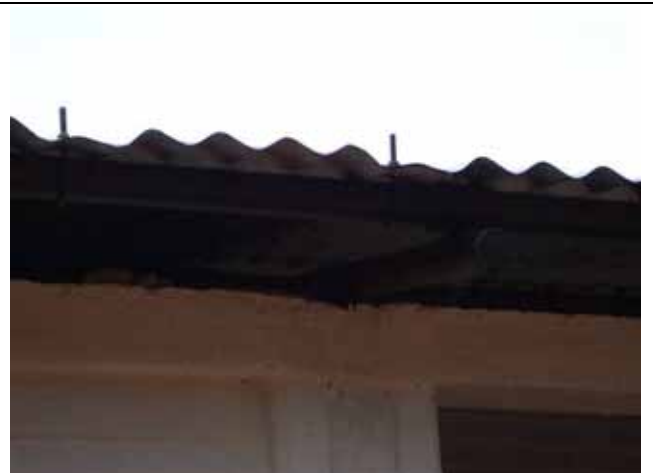
屋根材には、さび止めコーティング（黒色の塗料）を施した（全地域共通）
