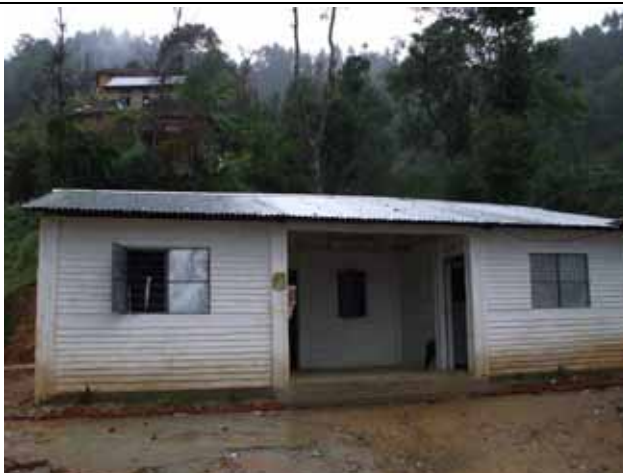
完成した簡易保健所。手前には花壇が作られている。
