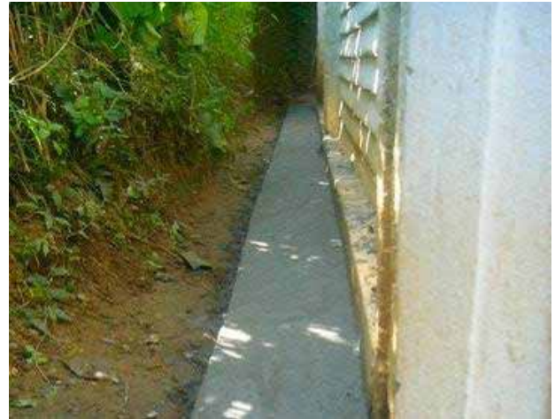
歩きにくかった建物の周りに犬走りを造った。
