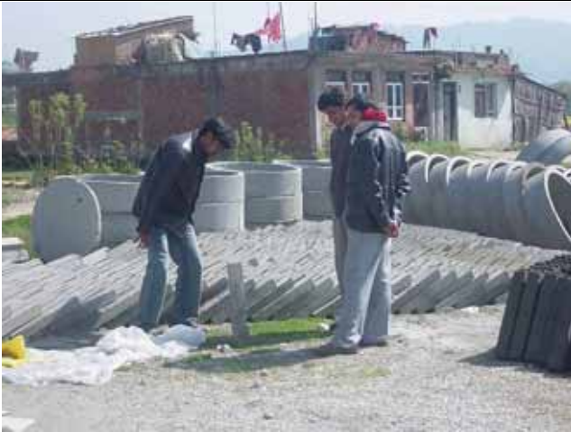
完成したブロックの質を確かめる現場監督、プロジェクト・マネージャー、プロジェクト技術者(左から)
