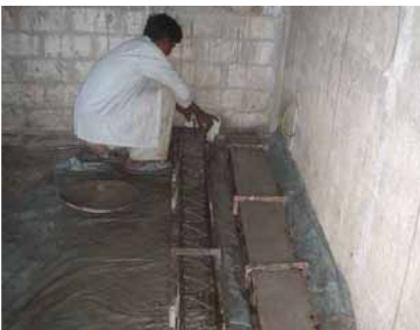
梁を製造している様子。
