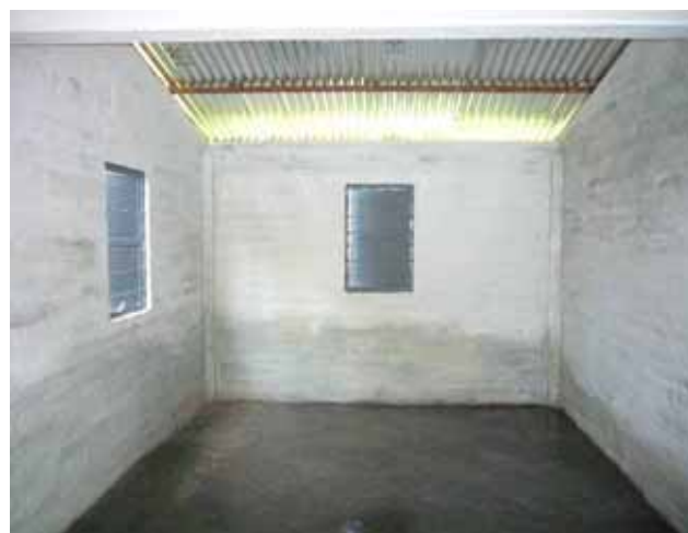
塗装中の内部
