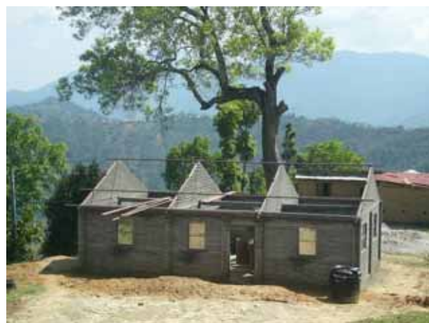
作業中の様子。
