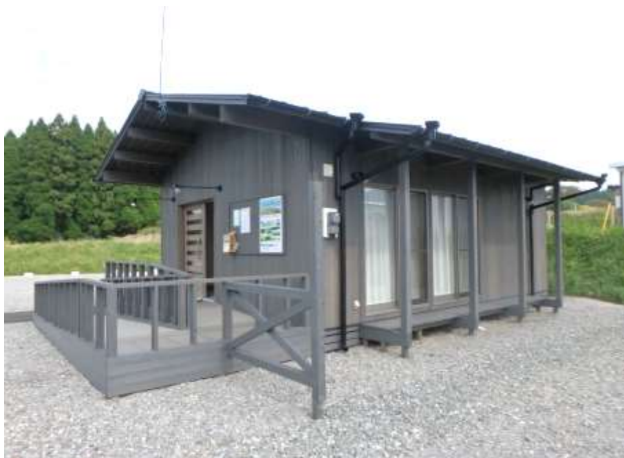
南阿蘇村仮設団地内にある「みんなの家」
